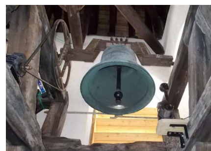
L'horloge électronique, les contacteurs électriques et les moteurs des cloches de la Collégiale.
