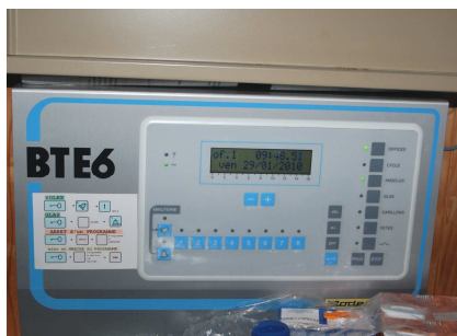
L'horloge électronique, les contacteurs électriques et les moteurs des cloches de la Collégiale.
