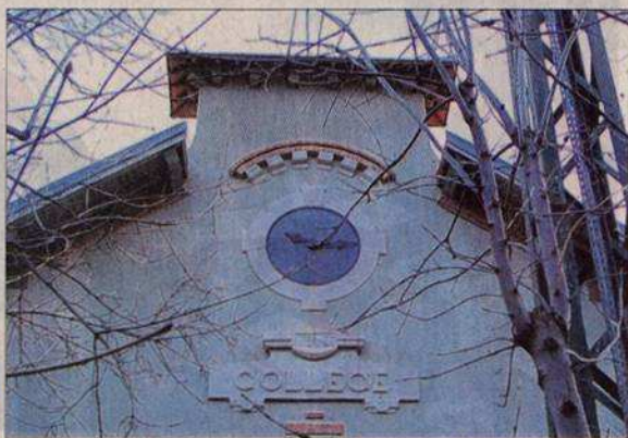
L'horloge restaurée sera inaugurée le 18 mai. Lors de l'anniversaire de l'établissement, des visites des sous-sols aux combles seront possibles.
