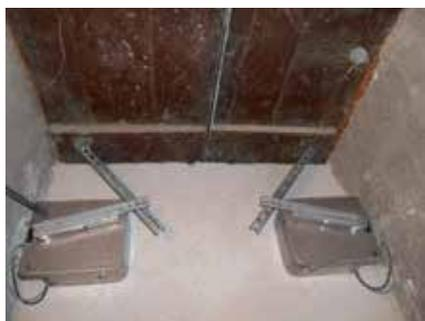
*Fig. 16 - Les portes sont fermées par les deux actionneurs (source : projet HdA).*
