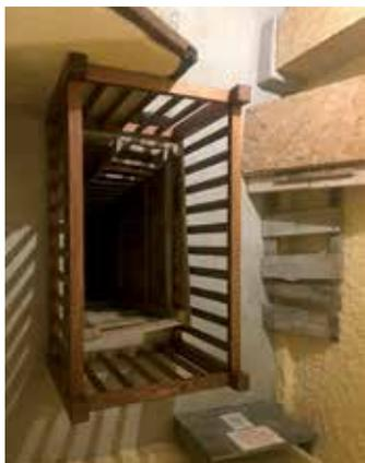
*Fig. 22 - Le puits de la descente des poids peut accueillir les poids en sécurité (source : projet HdA).*
