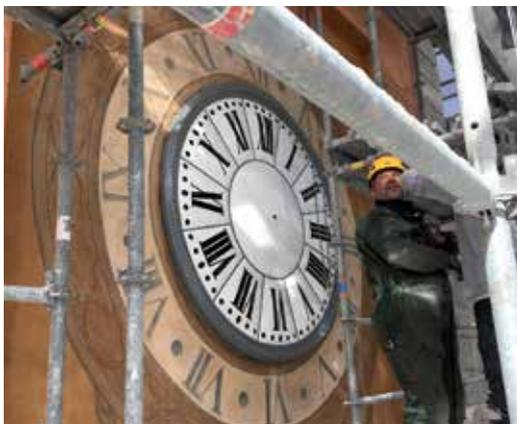
*Fig. 23 - Le cadran émaillé restauré est reposé (source : projet HdA).*
