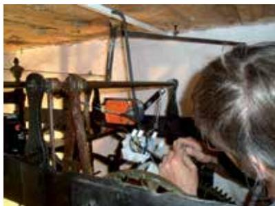
Fig. 14 - Câblage des servomoteurs aux Vigneaux avec Philippe Lepetit (source : projet HdA).
