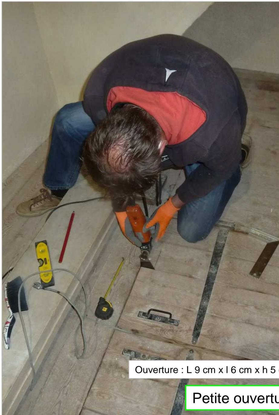
Ouverture : L 9 cm x l 6 cm x h 5 cm. Trou :  $\phi$  11,94 mm et L 36,7 cm.
