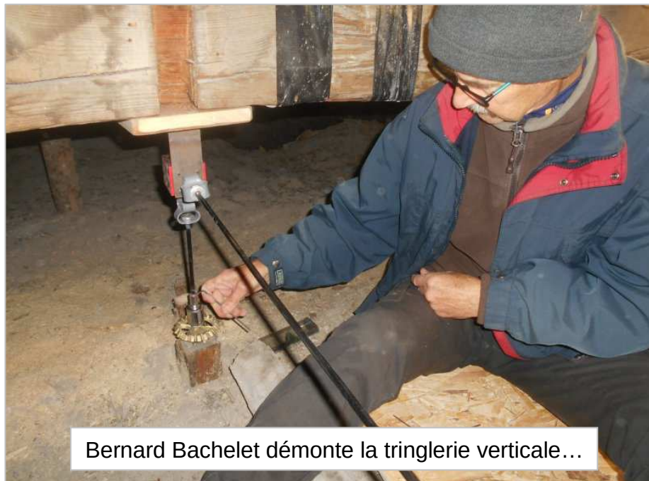
Deux cales en bois pour limiter l'élasticité du cardan.
