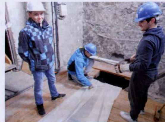
Mise en place du poliane sur le plancher de l'échafaudage
