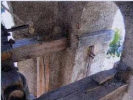
← Blocage du beffroi sur la maçonnerie
