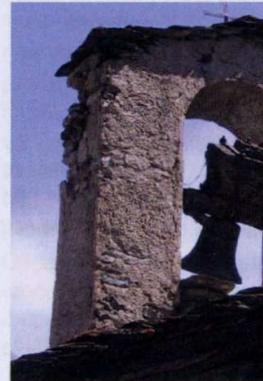
← Mauvais état de la maçonnerie
