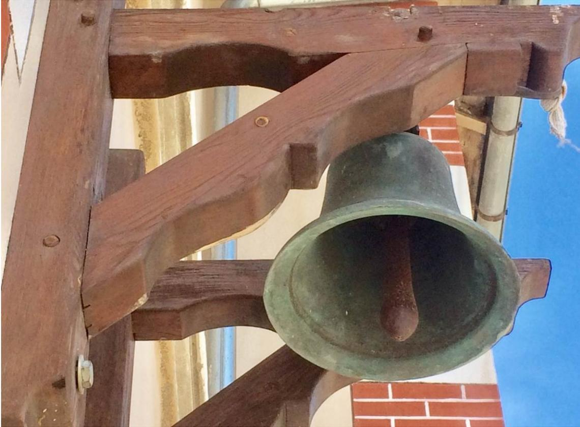
Le bois de la console est abimé à cause de l'exposition aux éléments climatiques et l'absence de protection. Les tourillons du joug de la cloche sont directement posés sur le bois de la console, il n'y a pas de palier pour réduire les frottements lors de la mise en volée de la cloche. Les parties métalliques du joug et le bras de sonnerie ne sont pas protégés contre la corrosion.
