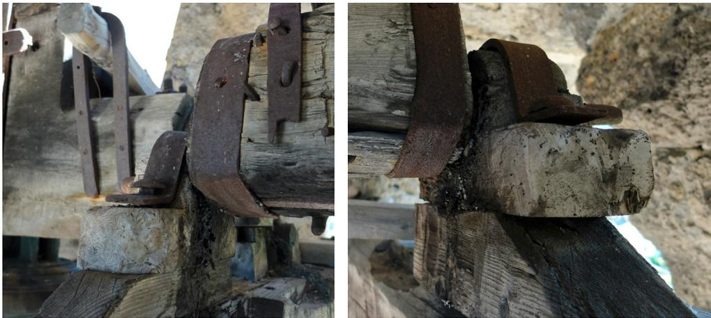
Détail des paliers à l'ouest à gauche et à l'est à droite.
