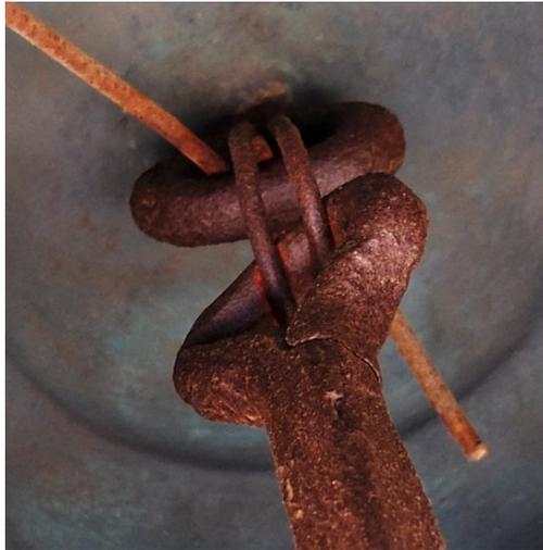
Détail de la tige métallique servant de baudrier et de la fissure de la boucle du battant.
