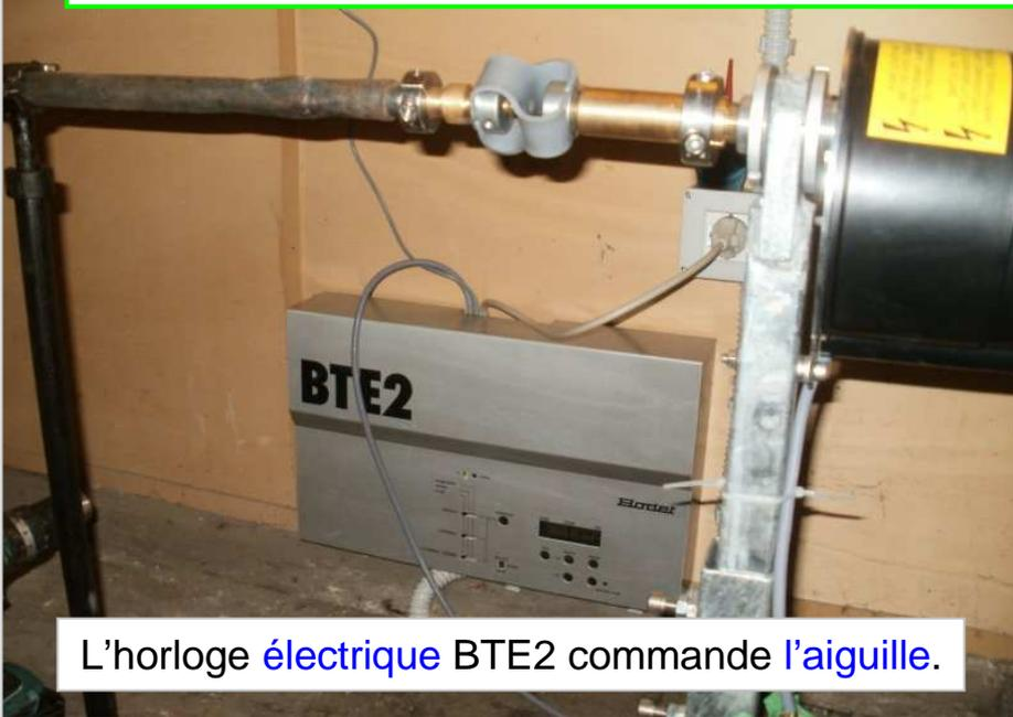
L'horloge **électrique** BTE2 commande **l'aiguille**.
